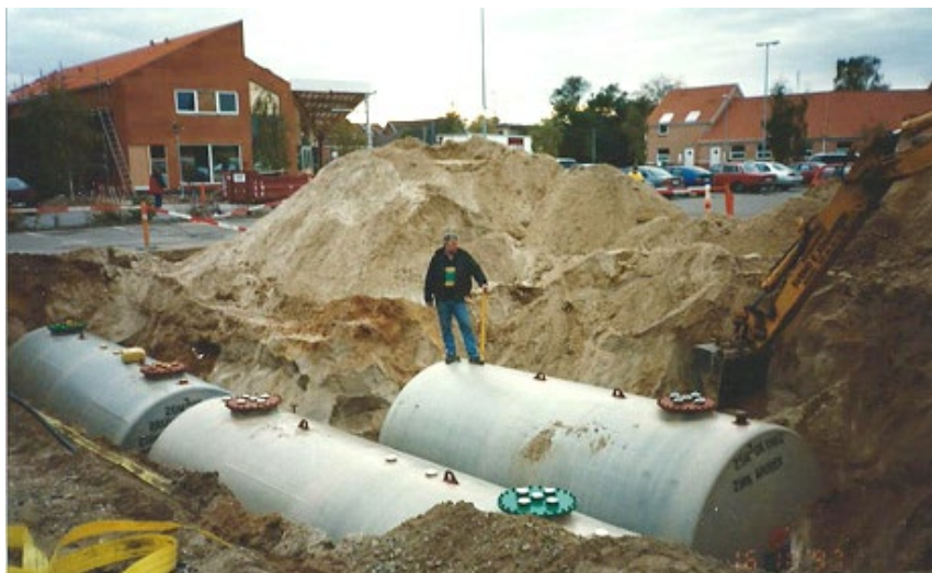
I 1997 blev der gravet tre 2.000-liters og en 2.500-liters jordtanke ned til det nye OK-tankanlæg. Anlægsarbejdet blev udført af Svend Erik Johansen, Auning Entreprenørforretning A/S.
