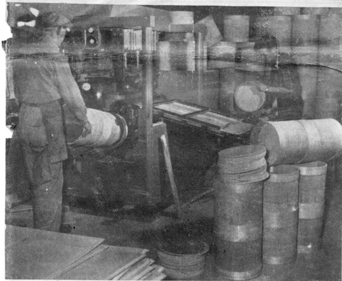
Paa denne Cylindermaskine, der er konstrueret af Fabrikant Robert Jensen, foregaar den vigtigste Proces i Fremstillingen af Fustagerne, nemlig selve Samlingen. Cylindermaskinen bøjer og sammenlimer Fineret og paasætter samtidig Yderbaandene. Med denne Maskine som Mønster er der som nævnt i Artiklen sat en Produktion i Gang i Norge.
