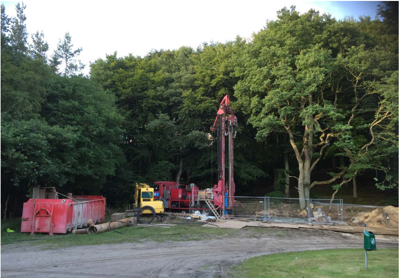
Etablering af den sydlige brønde ved den store parkeringsplads i Løvenholmskoven
